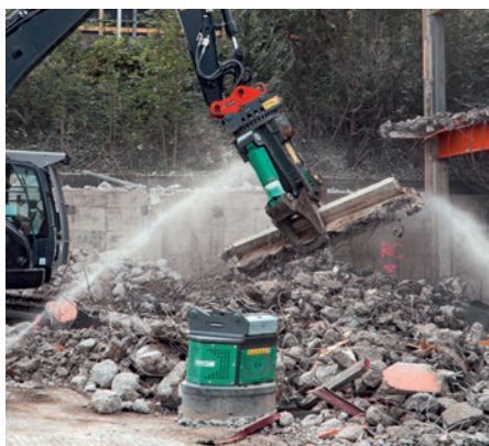
Ein perfektes Zusammenspiel fürs Baustoff-Recycling: Egli Betonbeisser und Egli Magnet.
